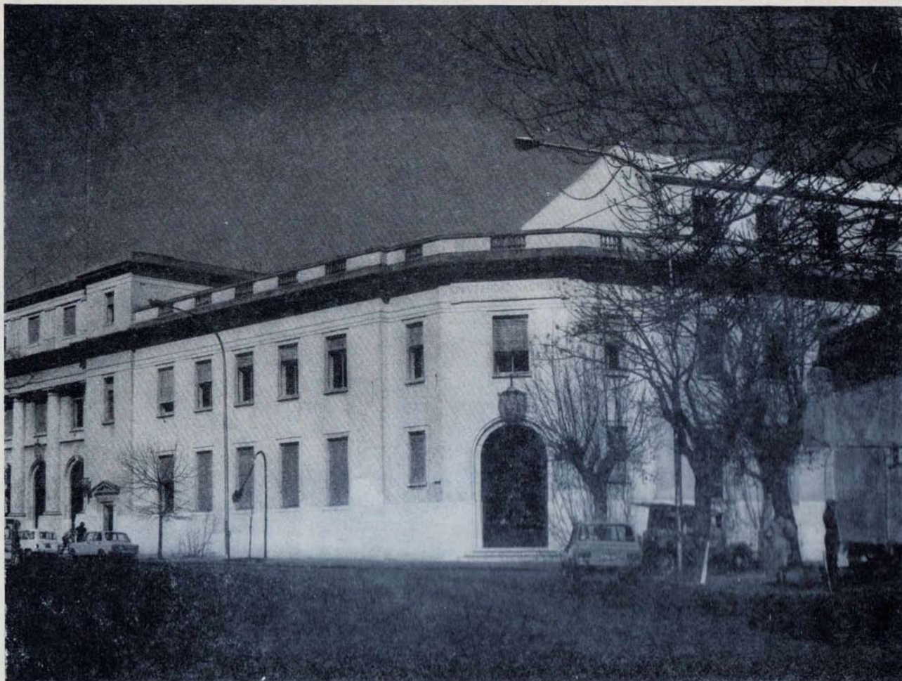
Edificio de la Facultad: acceso al salón de actos por la ochava frente a plaza Rocha.
